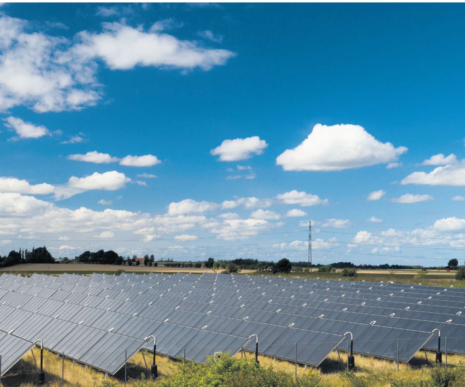
Høje Taastrup fjernvarme. Solvarmeanlæg. Solvarme. Solceller. Solcellepark. Høje Taastrup fjernvarme. Solvarmeanlæg. Solvarme. Solceller. Solcellepark. Foto: Torben Klint Torben Klint
