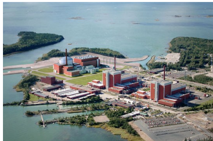
Olkiluotoværket som det vil se ud, når OL3 længst til venstre er færdig i 2011.
